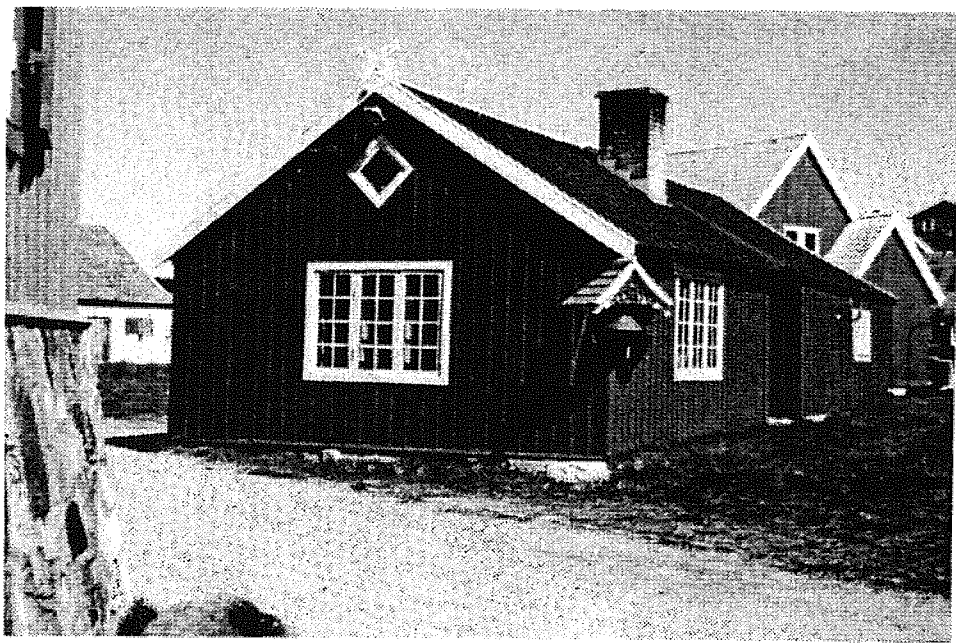
Tømrervækstedet B-17 fik sin nuværende skikkelse år 1900. Det er en bræddekædt bindingsværksbygning.
