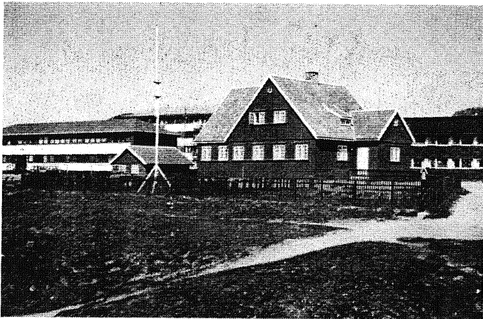
Præsteboligen B-86 er opført i 1922 og udvidet i 1936. Det var begge gange Helge Bojsen Møller, der stod for byggeriet.
