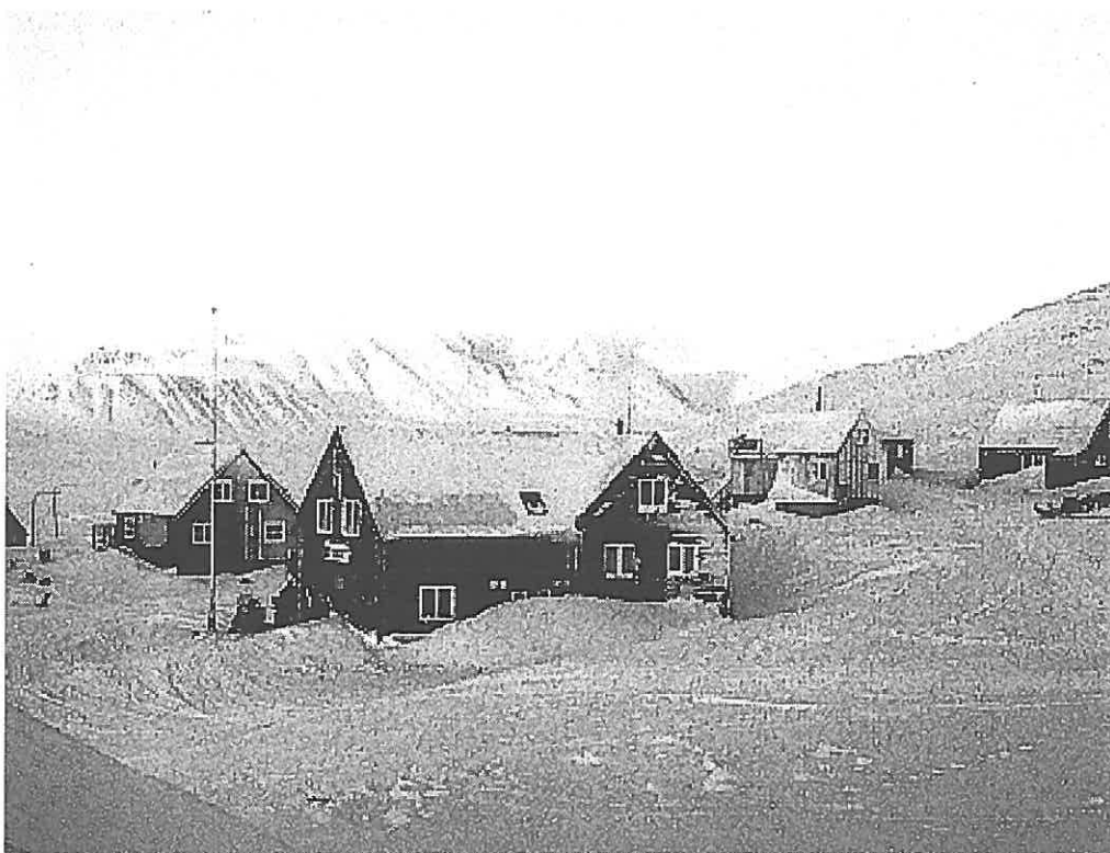
Kommunekontoret i Ittoqqortoormiit
