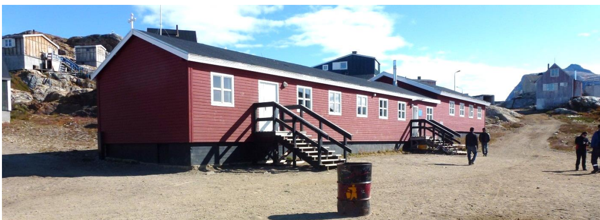
Asseq 14. Tiilerilaami atuarfik.
