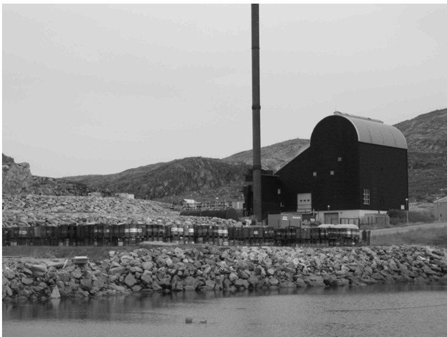
Forbrændingsanlægget ved Sarfaarsuit
