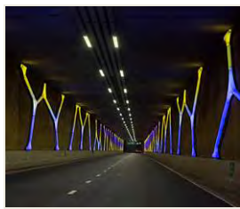
Figur 14. Brug af lys i tunnel
