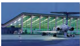
Figur 15. Eksempel på terminalbygning, Aalborg Lufthavn
