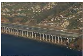
Figur 17. Madeira lufthavn – Eksempel på søjlefundament
