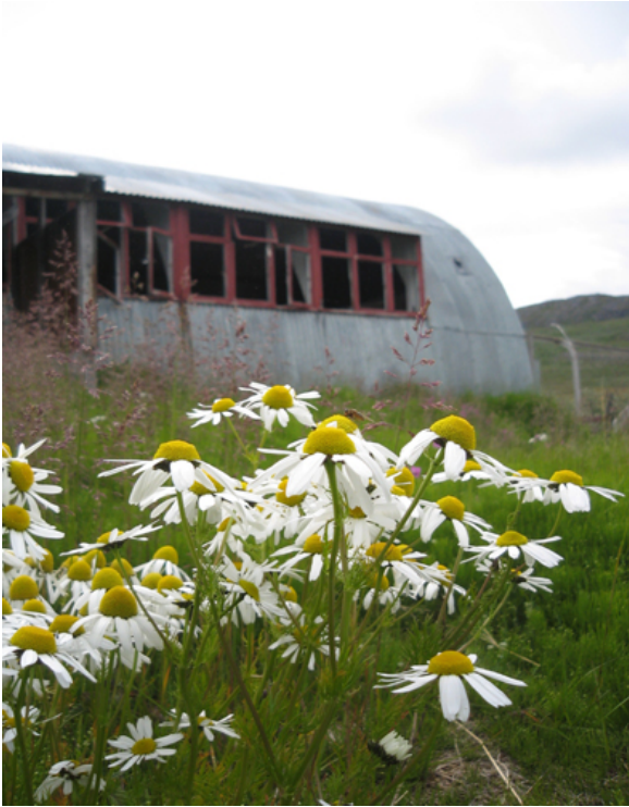
Figur 1: De eksisterende bygninger giver stemning og historie til stedet
