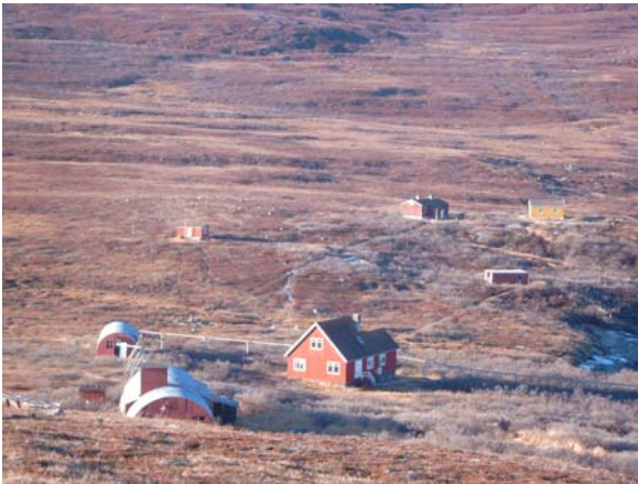
Figur 5: Området set fra øst. I forgrunden: rensdyrstation, pakkehal og bestyrerbolig. I baggrunden: mindre bygning, renvogterbolig, el-værk og indkvarteringshytte.
