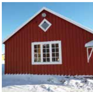
(16) B-17 Sannavitoqaaq / Opr. tømrerværksted
